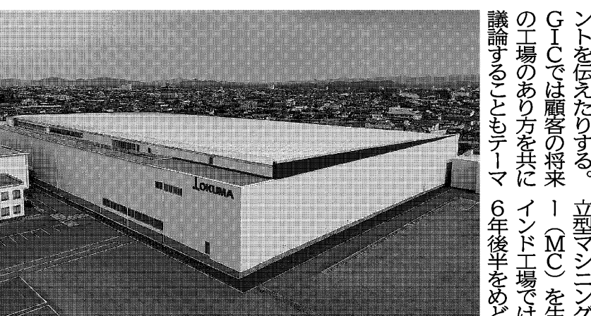
オクマが江南工場に新設した「ドリームサイトエンジニアードソリューションズ」
