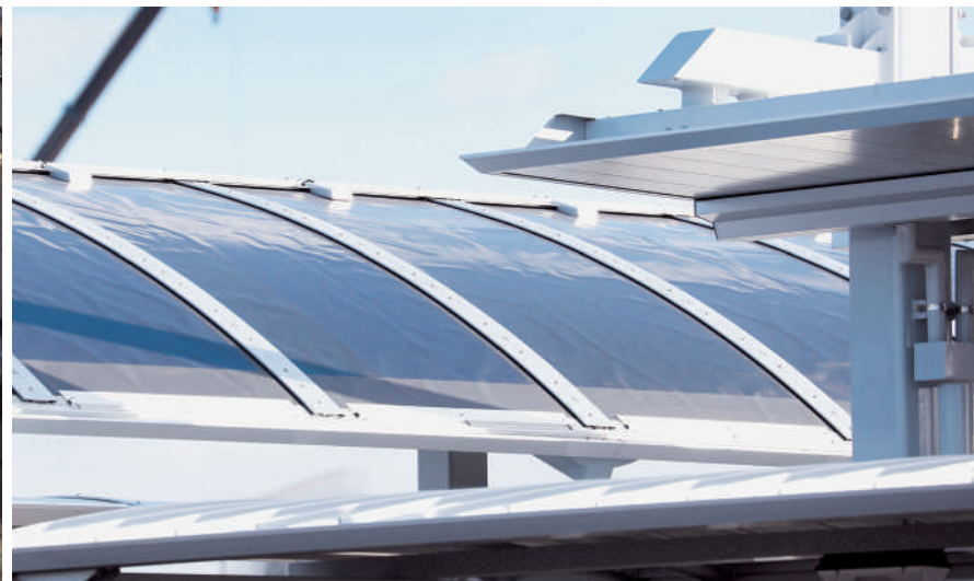
⑥脱炭素と安全保障の観点から再生可能エネルギーの導入拡大が急がれる(大阪府・関西万博でバススターミナルの屋根に設置されたペロブスカイト太陽電池)6面に 関連記事
