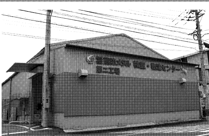
熊防メタルの検査・物流センター外観
