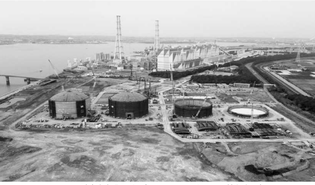
JERA碧南火力発電所で商用アンモニアタンク4基を建設中
