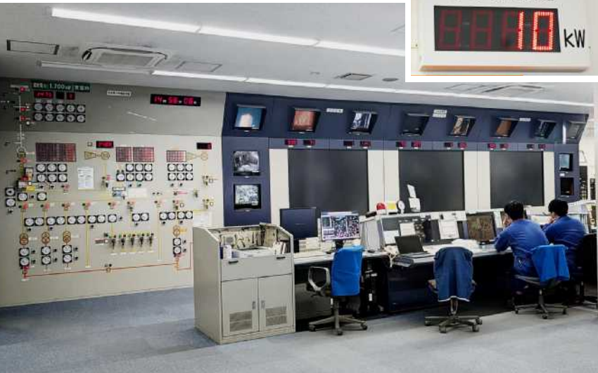
中央制御室。機器冷却塔の冷却水を利用した冷却水小水力発電も行(右上)
