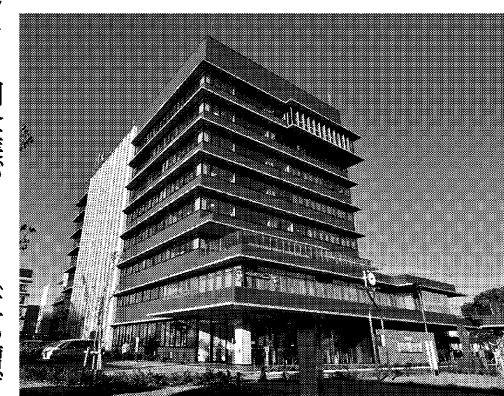
産業振興を図る越谷市(越谷市役所の外観)
