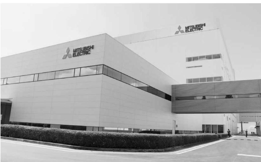
三菱電機が熊本県菊池市に建設した新工場棟。自動搬送機などの投入で生産効率を向上させる
