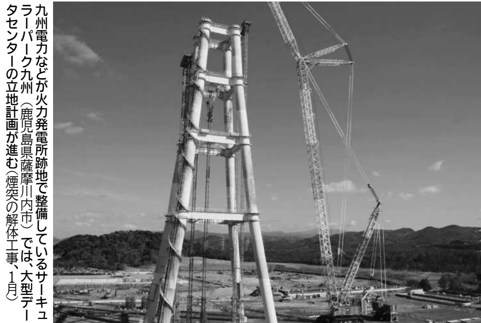
九州電力などが火力発電所跡地で整備しているサーキュラーパーク九州（鹿児島県薩摩川内市）では、大型データセンターの立地計画が進む（煙突の解体工事、1月）
