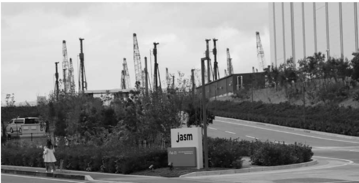
■台湾積体電路製造（TSMC）の製造子会社であるJASM（熊本県菊陽町）は第1工場に隣接する第2工場の建設を始めた。2027年12月の操業開始を見込む
