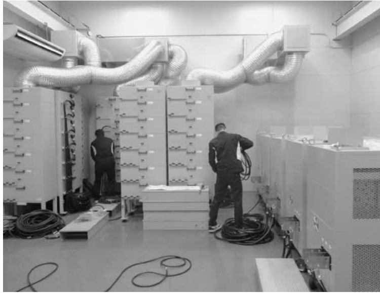
伊勢原第3工場では大電流発生装置や負荷抵抗装置を備える温度試験室も増強
