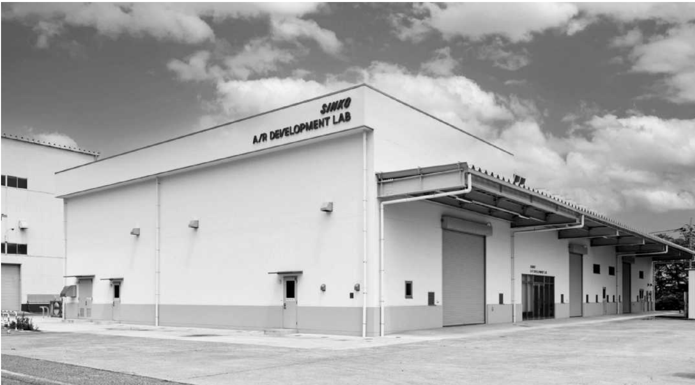
空調機の実負荷能力試験が可能な総合実験棟（新晃工業提供）
