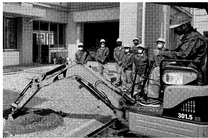
建設機械操作も土木工事の基本の一つ
