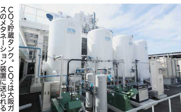
DAC装置で空気から分離・回収されたCO 2 濃度は95%以上
