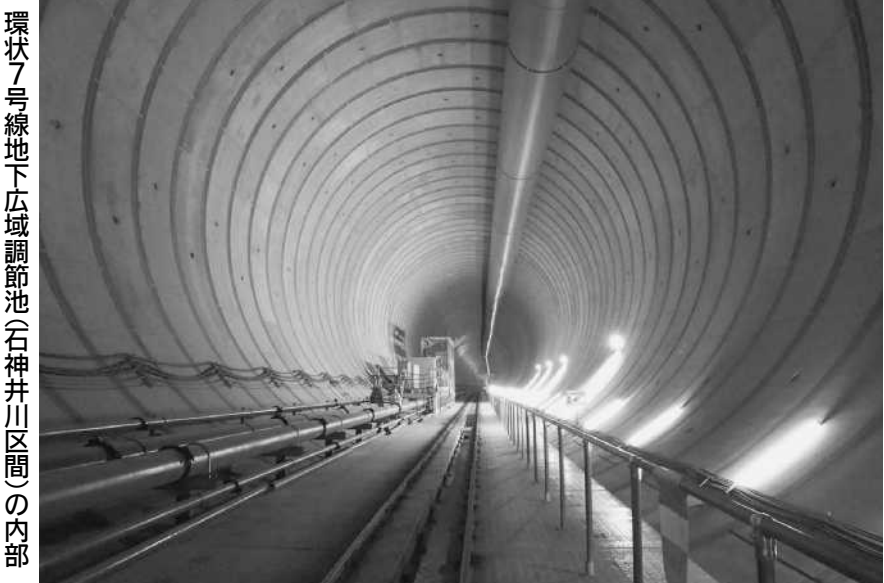
環状7号線地下広域調節池(石神井川区間)の内部
