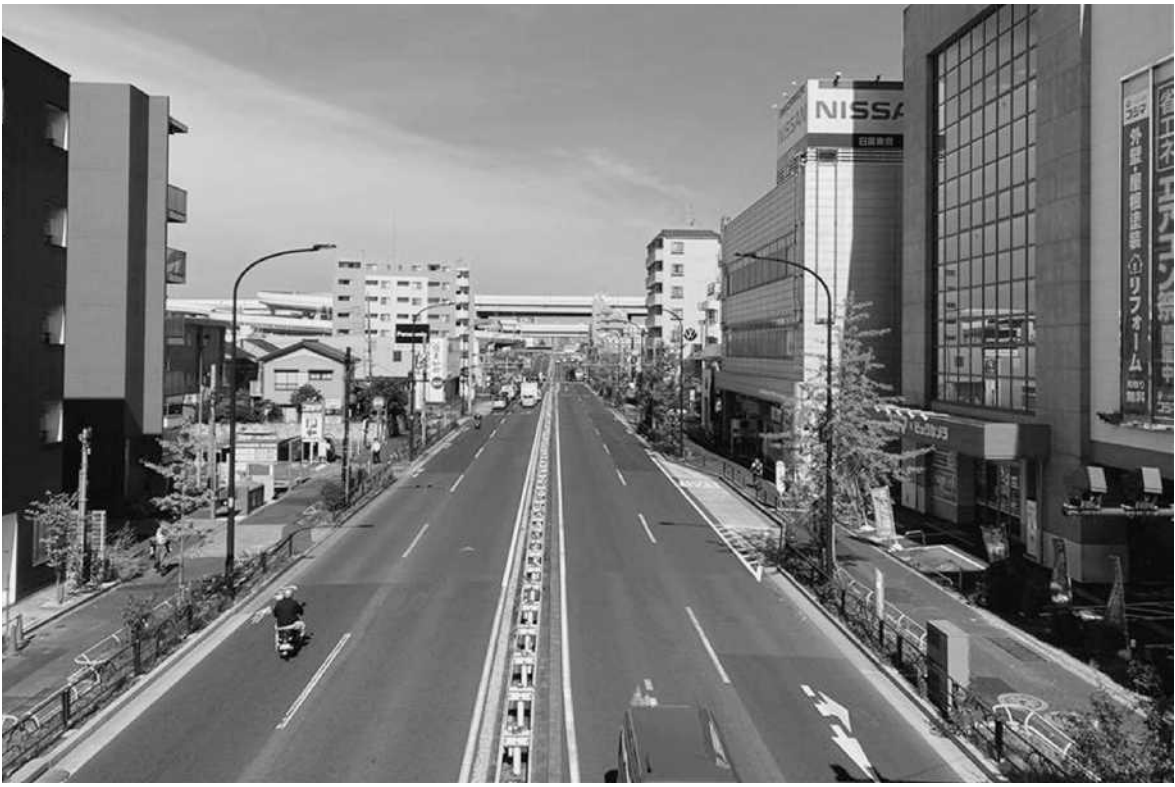
無電柱化工事完了後の環状7号線(足立区加平)
