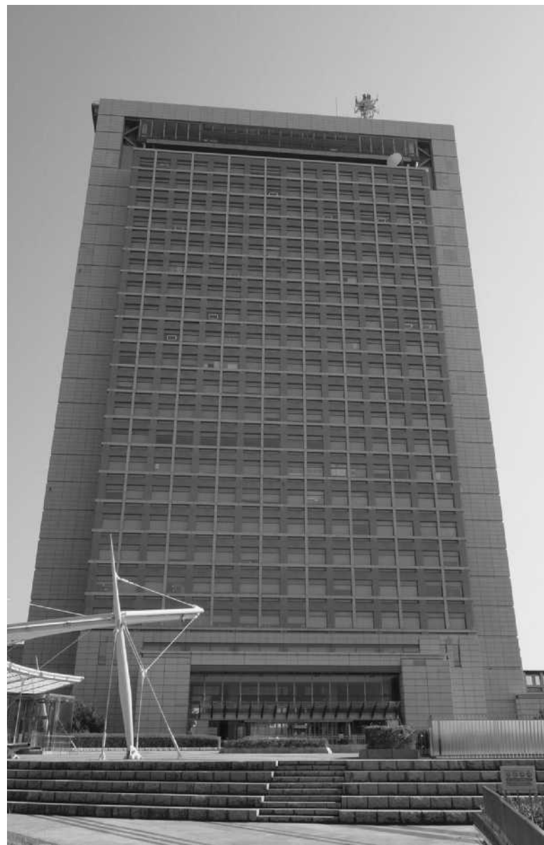
人口減少時代を見据え、持続可能な産業基盤づくりが加速する（茨城県庁舎、水戸市）
