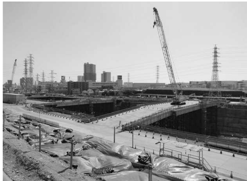
リニア中央新幹線神奈川県駅(仮)の建設工事現場
