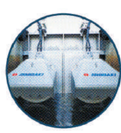
雨水排水ポンプ
