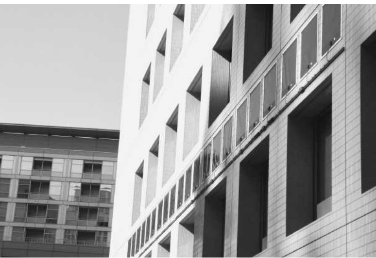
ペロブスカイト太陽電池は社会実装を目指す動きが加速している（NTTデータによる高層ビル壁面での実証実験＝24年12月）
