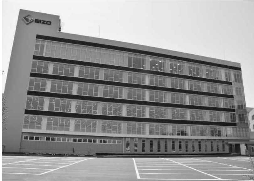
E I Z Oが本社敷地内に建設した新技術棟
