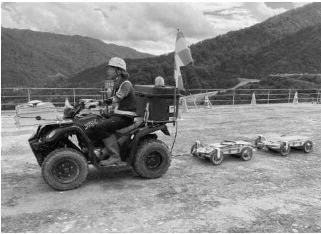
「Geo-DX Compaction」による締固め品質管理（鹿島）
