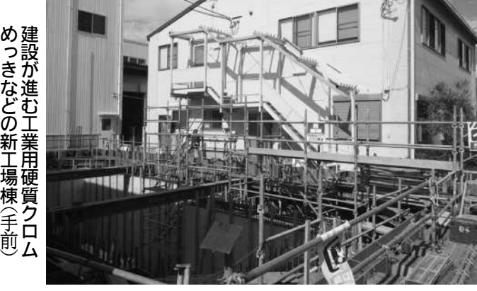
建設が進む工業用硬質クロムめっきなどの新工場棟（手前）
