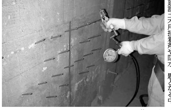
高圧樹脂注入プラグは接着剤を高圧注入することで、トンネルやダムなどのひび割れ補修や補強工事ができる
