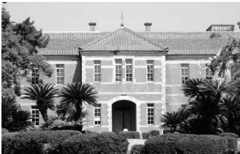
熊本大学のシンボル五高記念館。現在は地震被害からの復旧工事中(21年12月完了予定)
