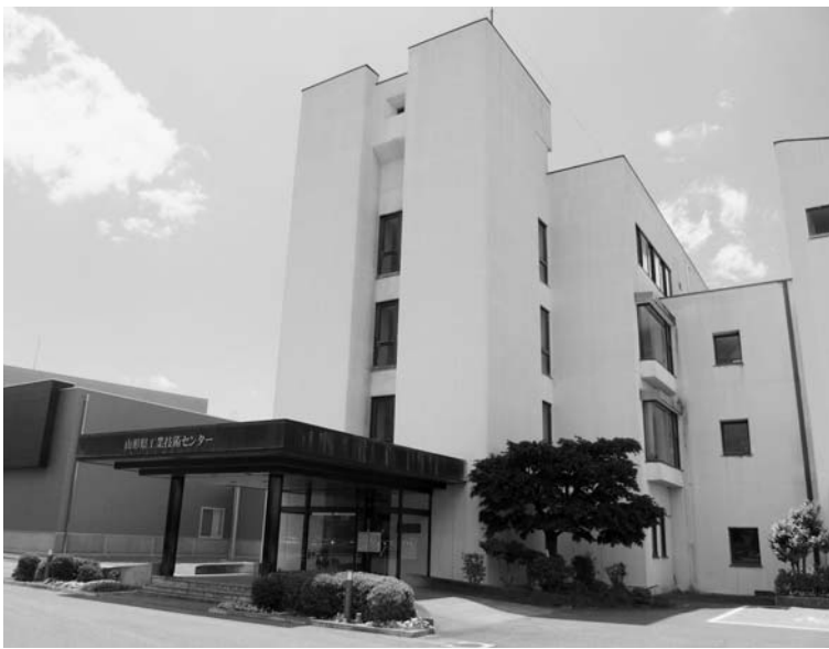
山形県工業技術センターの外観(左側建物が6月に開所したIoTイノベーションセンター)
