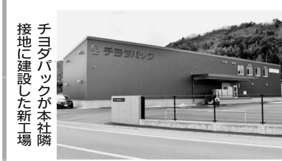
チヨダパツクが本社隣接地に建設した新工場
