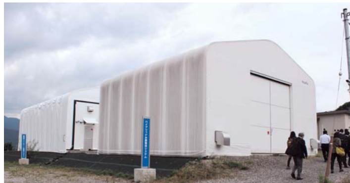
次世代フライホイール蓄電システムの実証施設
