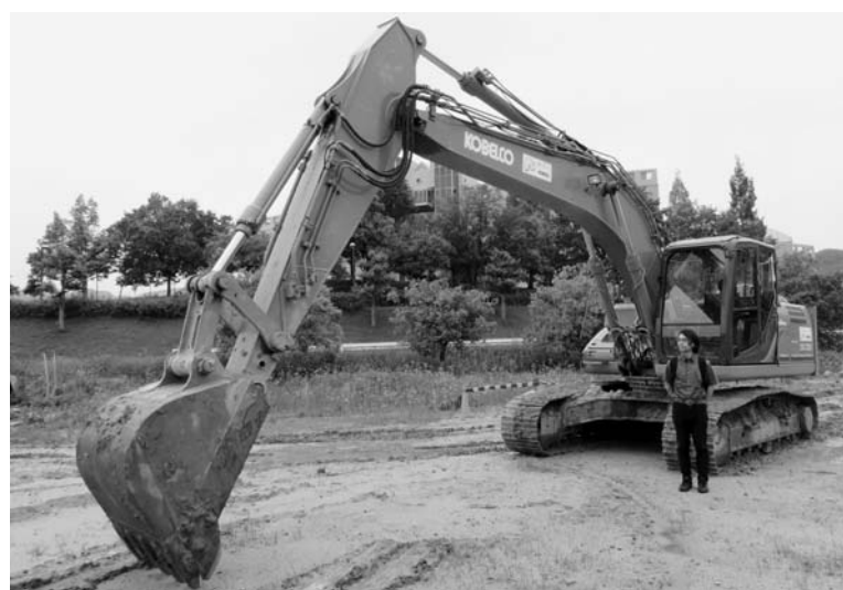
コベルコ建機の「A」による遠隔操作の研究のため、広島大に持ち込まれた油圧ショベル。前に立つのは伊藤卓助教
