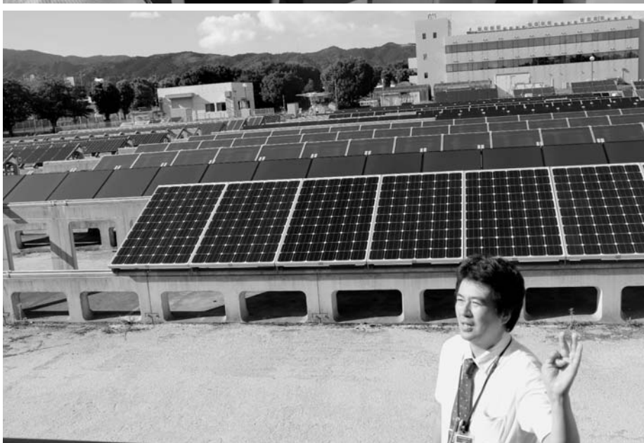
九州センターに設置する太陽電池。生涯発電率を調べている
