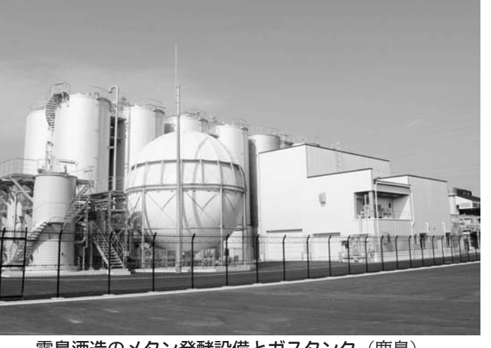
霧島酒造のメタン発酵設備とガスタンク(鹿島)
