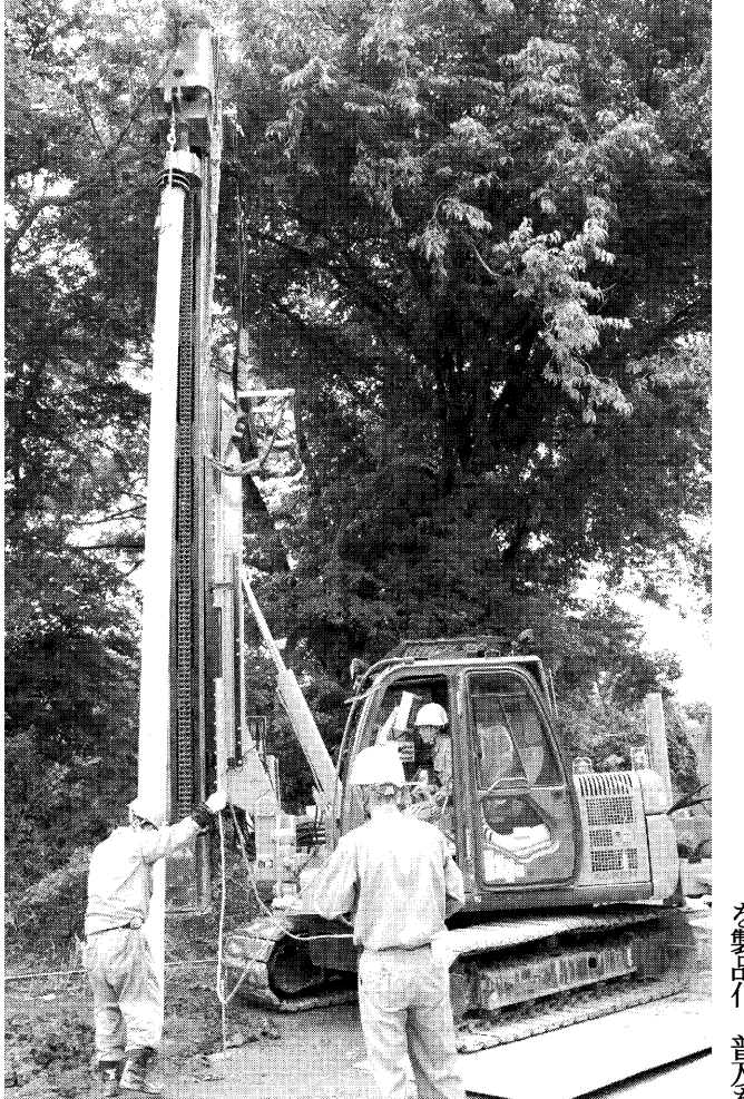
プレキャスト鉄筋コンクリート杭で地盤沈下抑制
