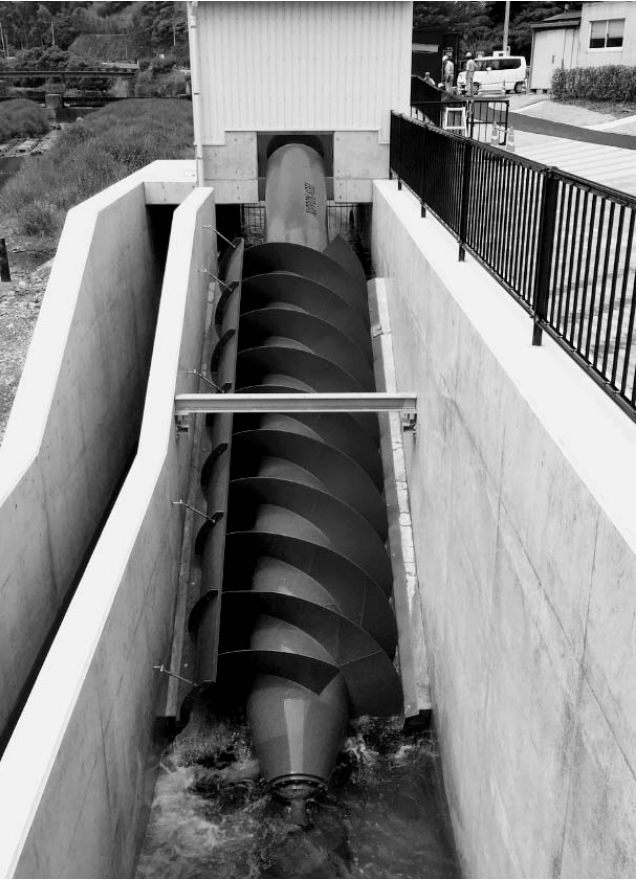
機を設置している。
