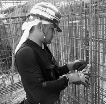
番線と番線カッターで型枠を結束していく
