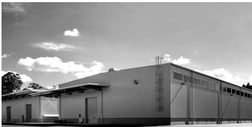
ちばリサーチパーク内に完成した太田プレスの新工場
