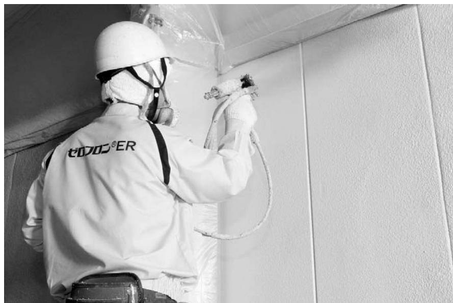
現場で対象物に吹き付けて施工する断熱材（旭有機材工業）
