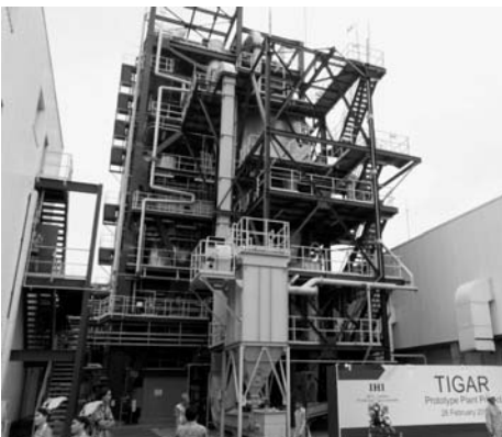
二塔式ガス化炉(IHI)
