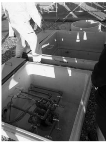
福島営業所に設置した自噴井による熱源設備
