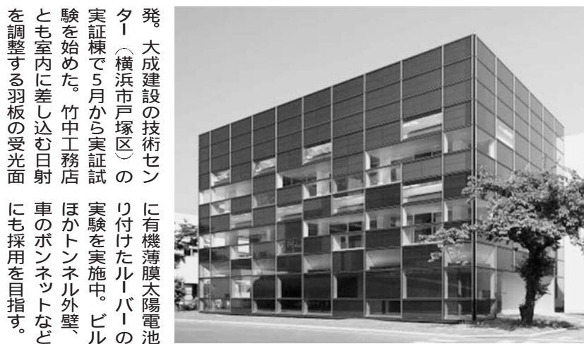
大成建設の実証棟外壁に設置され た有機薄膜太陽電池外壁ユニット
