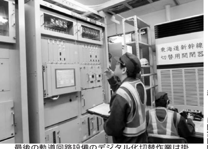
最後の軌道回路設備のデジタル化切替作業は掛川・豊橋間の沿線信号機器室などで実施された
