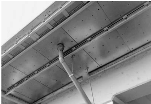
コンクリート橋の補強
