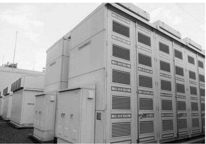
太陽光発電の電力安定化対策として大型電池の導入が始まった(日本ガイシのNAS電池)
