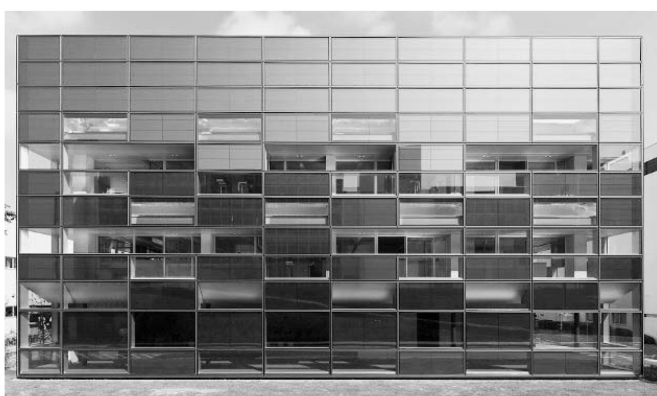
三菱化学と大成建設が壁面に有機薄膜電池を設置したZEB実証棟
