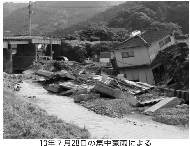
13年7月28日の集中豪雨による山口県須佐川の護岸崩壊の状況
