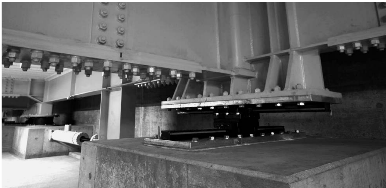
THK免震システム(直道転がり支承+粘性減衰装置)
