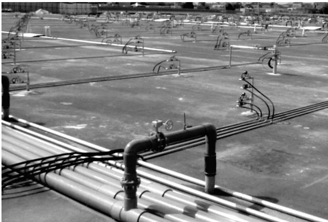
栄養塩液を空気とともに供給するバイオスパーキング工法の注入井戸
