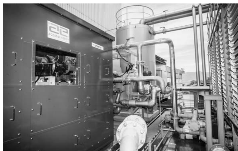
第一実業が国内に設置した米アクセスエナジー製の小型バイナリー発電システム
