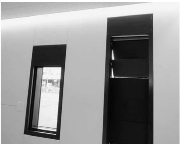
機器だけでなく自然換気窓などの建築部材も制御する
