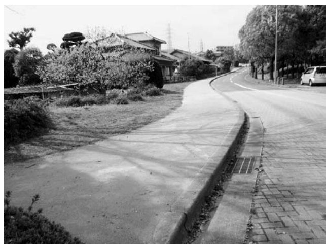
防草材「雑草アタック」を施工した遊歩道
