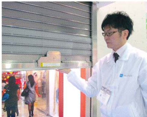
防火シャッター降下中の挟まれ事故を防ぐため、「エコセーフ」が装備されている
