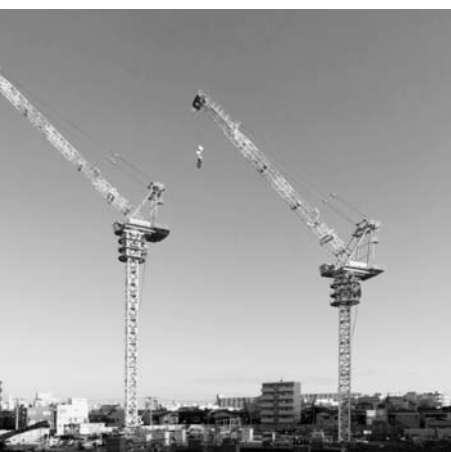
BIMとの連動で揚重作業を効率化する清水建設のタワークレーン「スマートクレーン」
