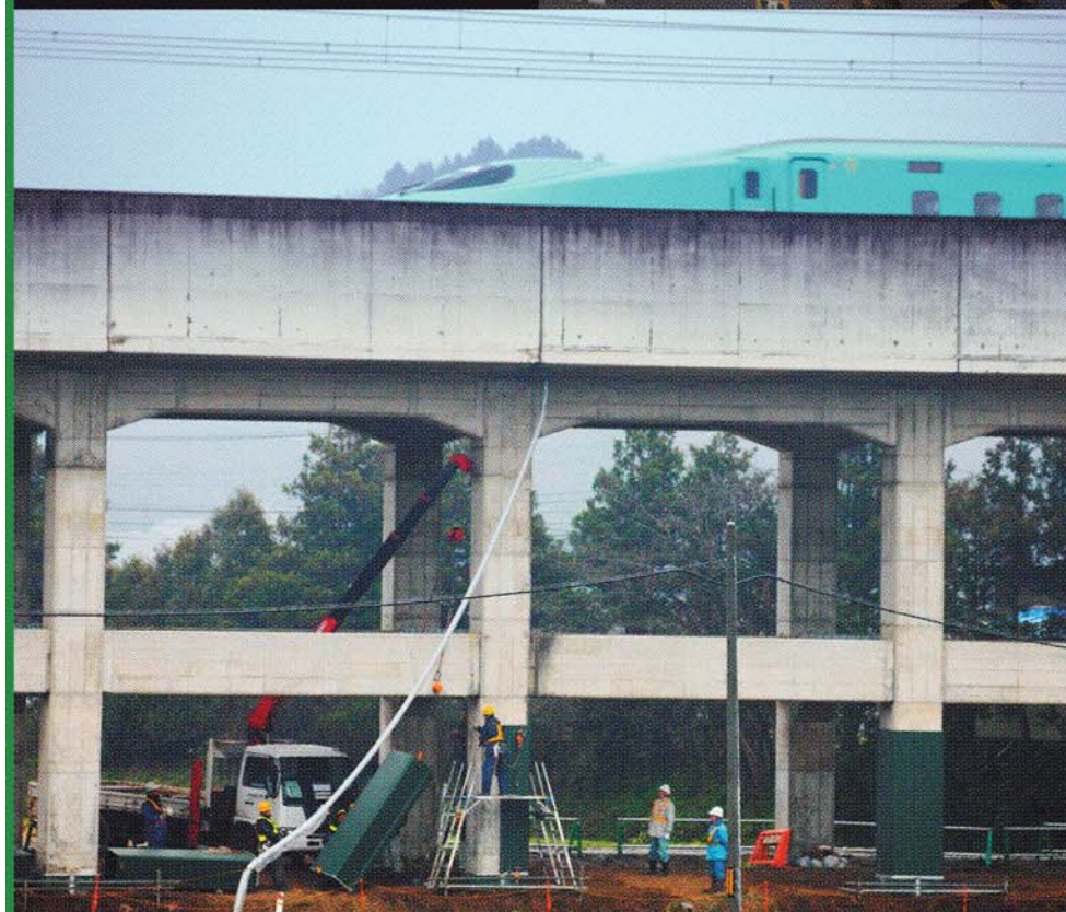
高架橋耐震補強工事
