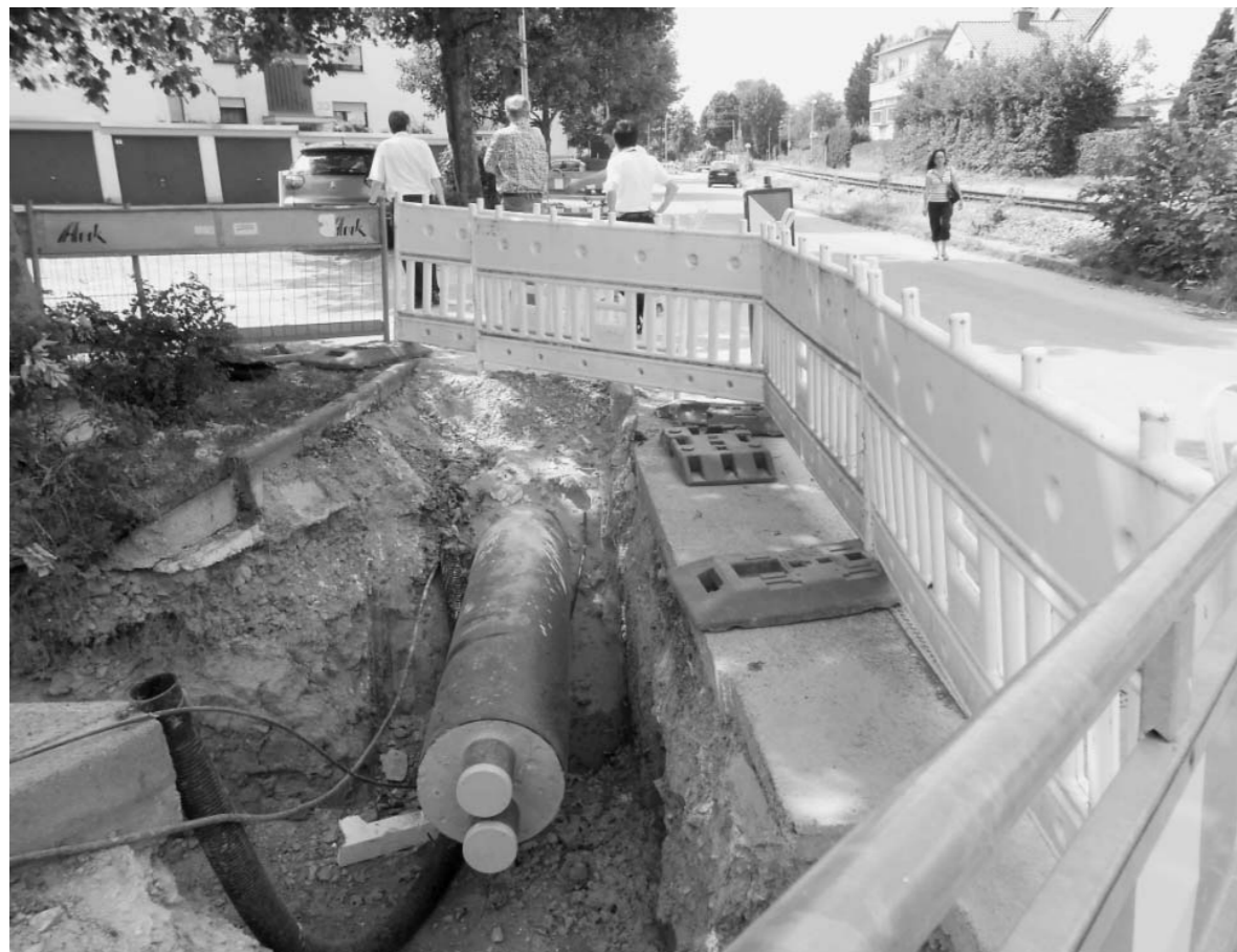
ドイツでは地域熱供給網のパイプライン工事が続いている
