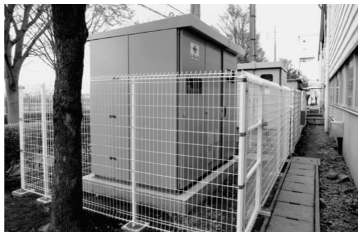
工場敷地内の「BUY電ゲートウェイ(OPB-100)」コンパクトさを活かし狭小スペースに設置されている
